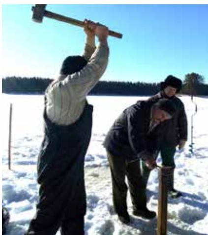
Установка дополнительной сваи водомерного поста на озере Боручье
